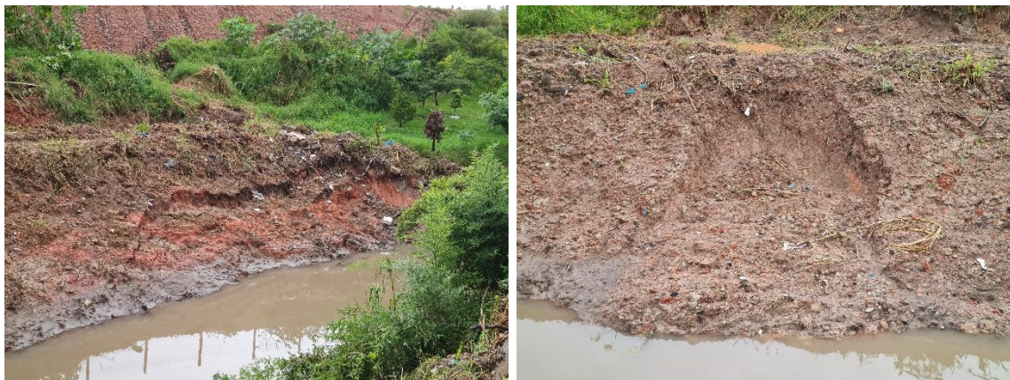
Figura 5 (a e b) - Deslizamentos das margens resultantes de desequilíbrio causado por obras de limpeza e "perfilamentos".
