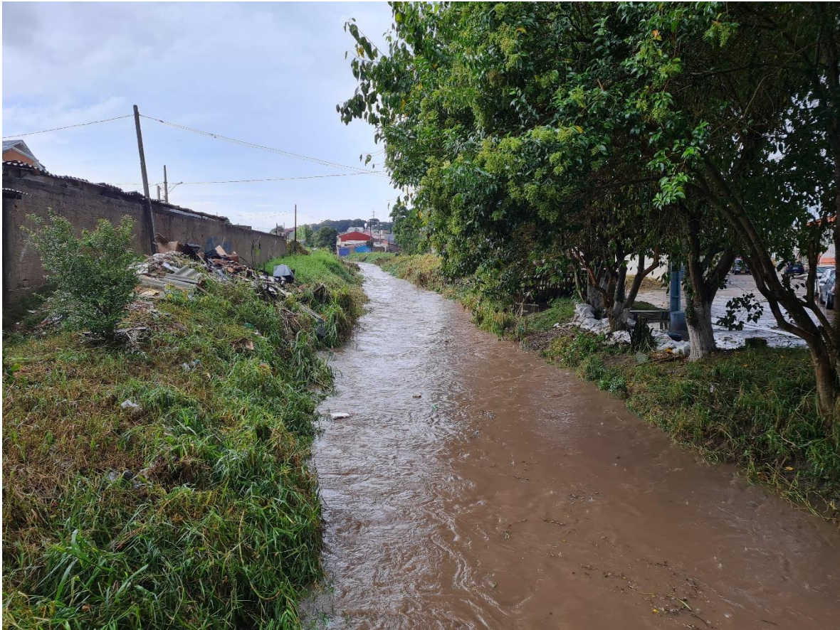
Figura 10 - Córrego Alto Boqueirão no dia 03março as 15:09h no limite de transbordamento do canal, com chuva registrada na estação pluviométrica mais próxima de 09mm em 10 minutos.
