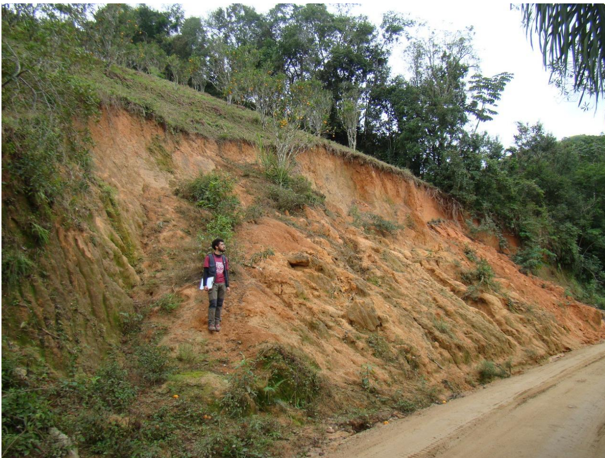
Figura 10 - Deslizamento translacional raso com sucessivas movimentações em encosta de estrada.
