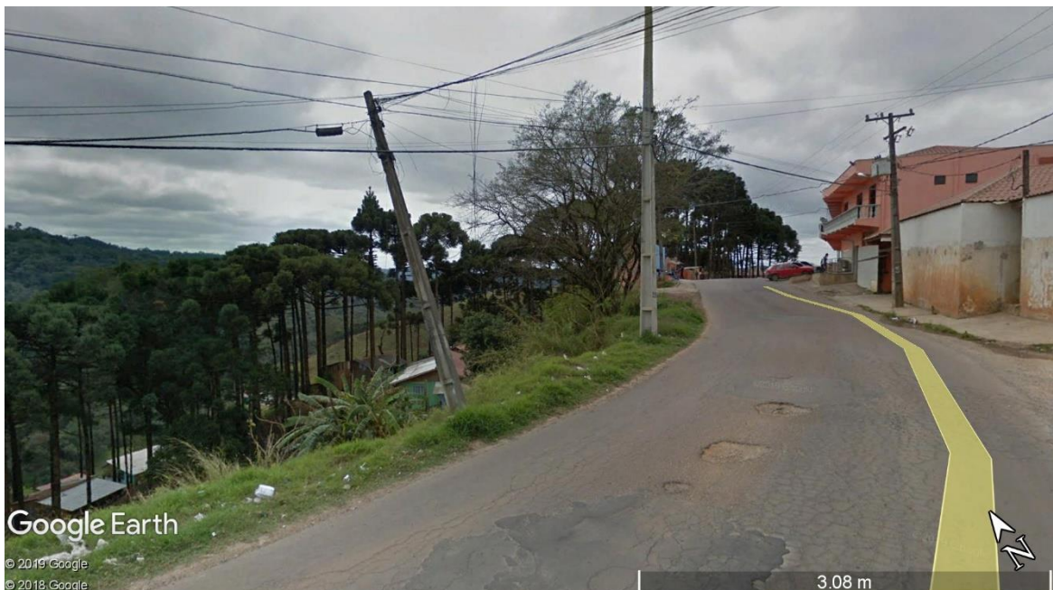
Figura 8 - Inclinação de poste localizado na encosta em movimento. Fonte: Google Earth, 2018.
