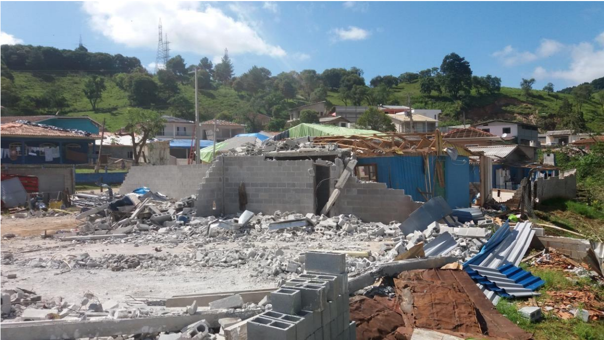
Figura 10 – Bairro Tacaniça em Rio Branco do Sul. Observa-se barracão tipo industrial completamente destruído e ao fundo conjunto de residências parcialmente destruídas. Intensa destruição de moradias de madeira e telhados, restando paredes de alvenaria e as edificações mais resistentes.
