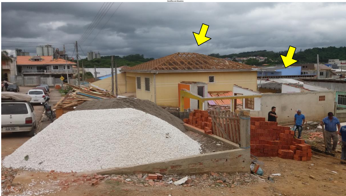
Figura 7 – Aspecto da Rua José Elias, indicando que a força do vento só excepcionalmente (rajadas) teve capacidade de destruir edificações mais resistentes.
