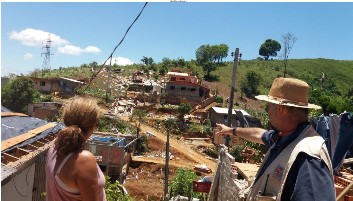
Figura 9 – Bairro Itau ou Canha. Área com intensa destruição de moradias de madeira e de telhados, restando a base de alvenaria e as edificações mais resistentes.
