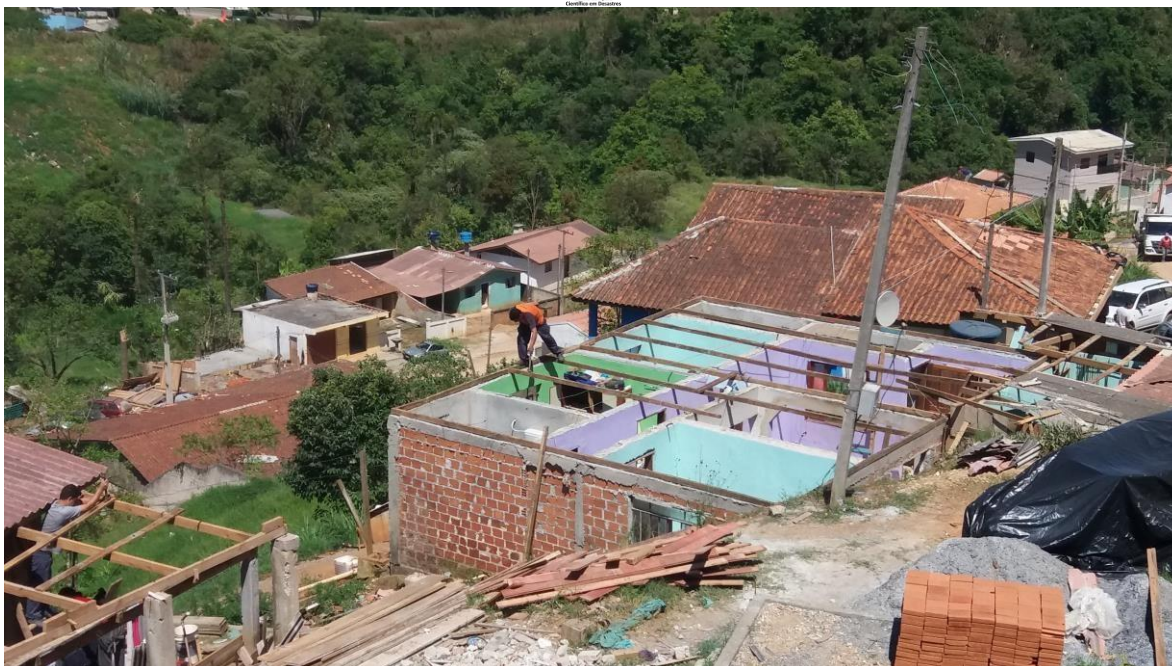
Figura 9 – O telhado desta casa realizou o maior voo detectado pela equipe para um objeto de grande porte. Foi arrancado e vou para o nordeste, atingindo a parte superior de uma casa +-50 metros acima na encosta e depois outra casa ainda 20m mais acima.
