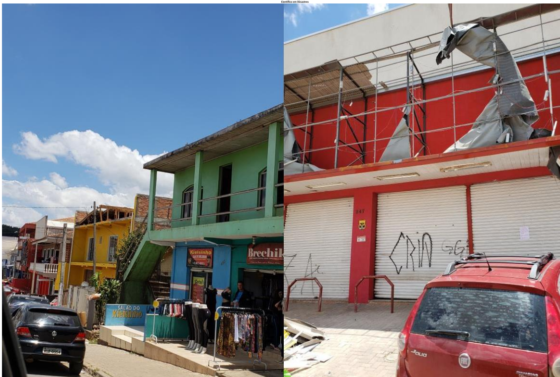
Figura 8 – Imagens mostrando aspectos do impacto no centro comercial de Itaperuçu, já na fase de recuperação.
