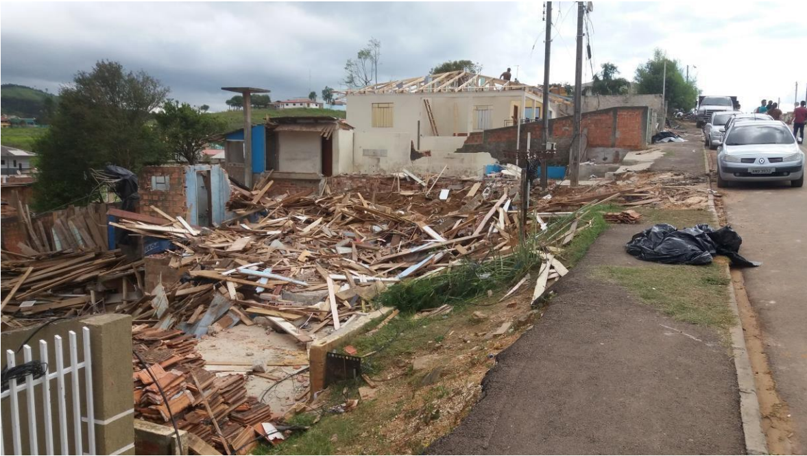
Figura 5 – Aspecto do lado Sul da Rua José Elias, mostrando resíduos de casas destruídas pelos ventos com evolução principal NE.
