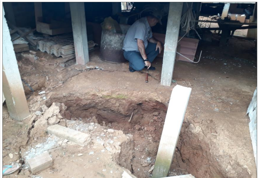
Subsidência na Vila São Pedro, rua sem nome. O terreno observado apresenta cerca de 1 metro de profundidade. Uma das pilastras tombou e pelo menos outras três estão comprometidas.
