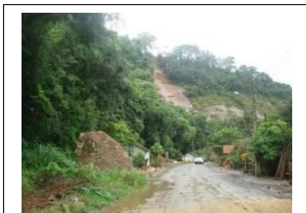
Figura 3 – Escorregamento de camada superficial em área íngreme
