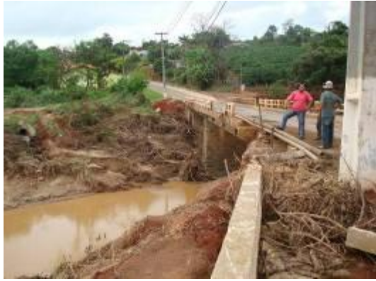
Figura 14 – Ponte sobre o rio Pinhalão
