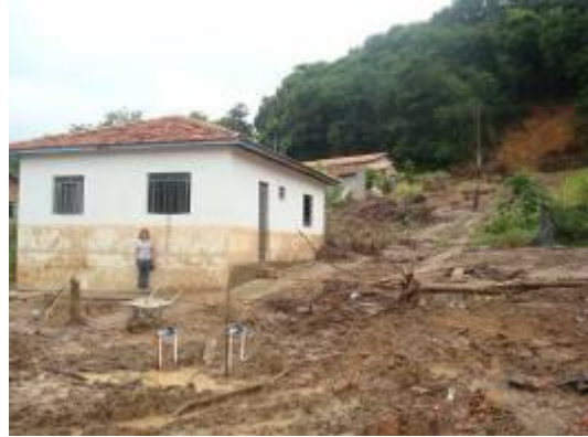
Figura 5 - Casa atingida por inundação e escorregamento
