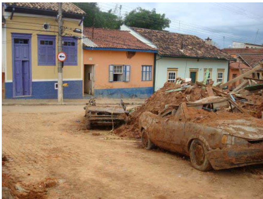
Foto 1: Área atingida pela inundação
