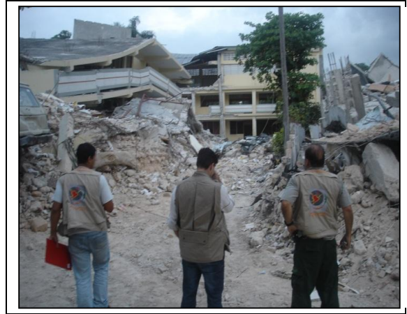
Figura 03: Equipe do CENACID realizando avaliação dos prédios afetados pelo desastre
