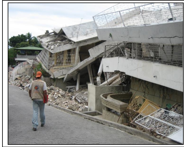
Figura 06: Detalhe da destruição provocada pelo terremoto do Haiti ocorrido em 12/01/2010
